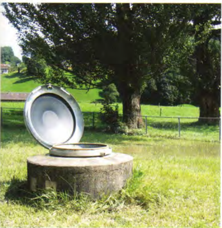
Brunnenschacht Grundwasserpumpwerk Giessen
