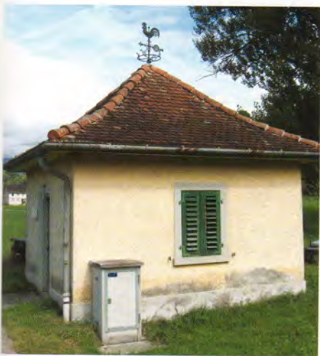
Grundwasserpumpwerk an der Linthbettstrasse
